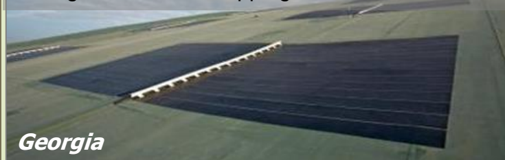
Solar geomembrane capping landfill
