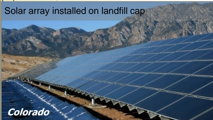
Solar geomembrane capping landfill
